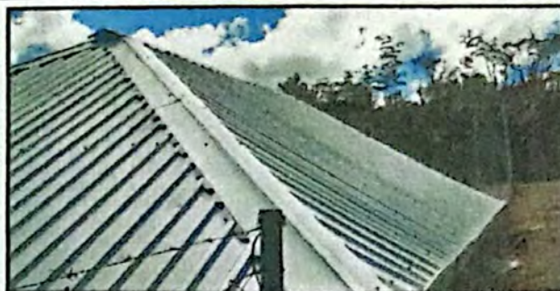
Foto 4: Sustitucion de lamina por lamina troquelada aluzinc calibre 26 de cocina
